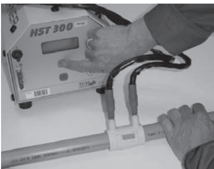
7. Die Kabelstecker in die Kontaktbuchse stecken.
