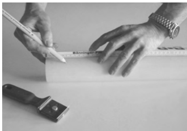
Muffeneinstecktiefe anzeichnen
