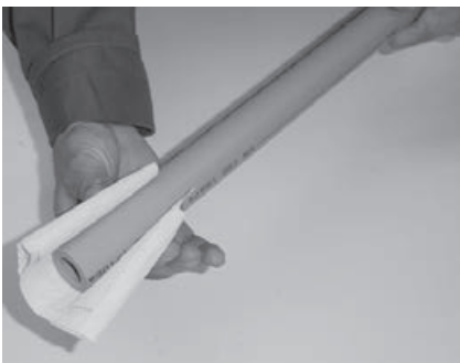
4. Fügeflächen mit Reiniger säubern.
